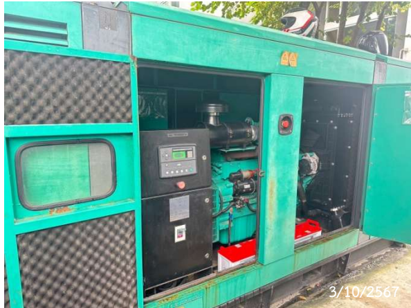
รูปที่ 2-31 เครื่องกำเนิดไฟฟ้าสำรอง (Generator)
