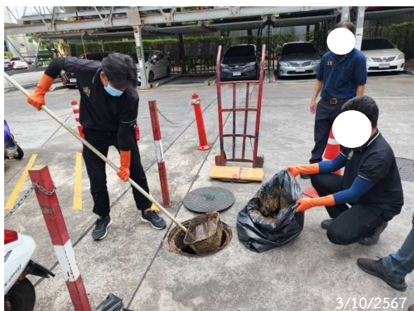
รูปที่ 2-9 เจ้าหน้าที่ตัดไขมันจากถังดักไขมัน
