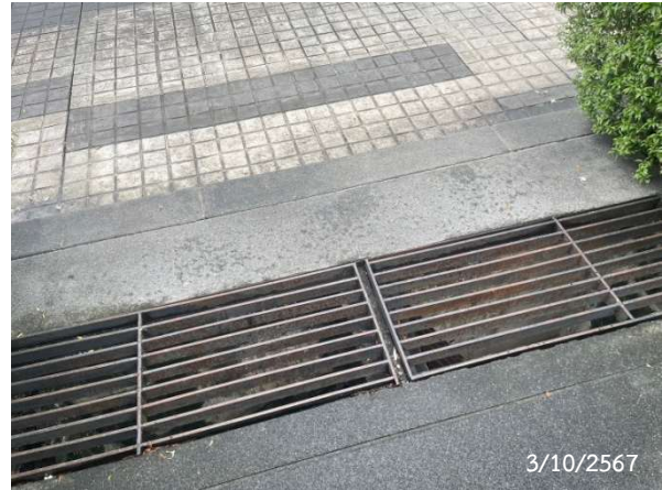
รูปที่ 2-23 บ่อพักน้ำและรางระบายน้ำของโครงการ
