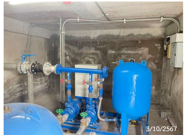
รูปที่ 2-14 Booster Pump
