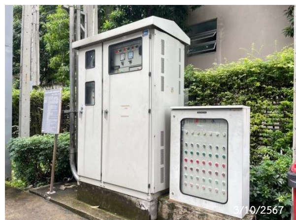
รูปที่ 2-30 หม้อแปลงไฟฟ้าและตู้ควบคุมระบบไฟฟ้า
