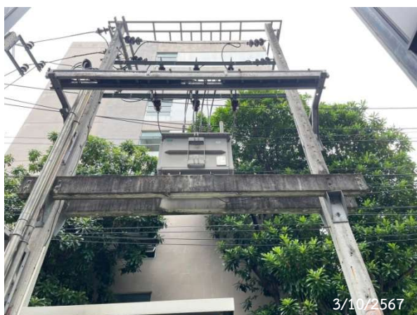
รูปที่ 2-30 หม้อแปลงไฟฟ้าและตู้ควบคุมระบบไฟฟ้า
