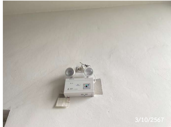
รูปที่ 2-32 ไฟฟ้าส่องสว่างฉุกเฉิน
